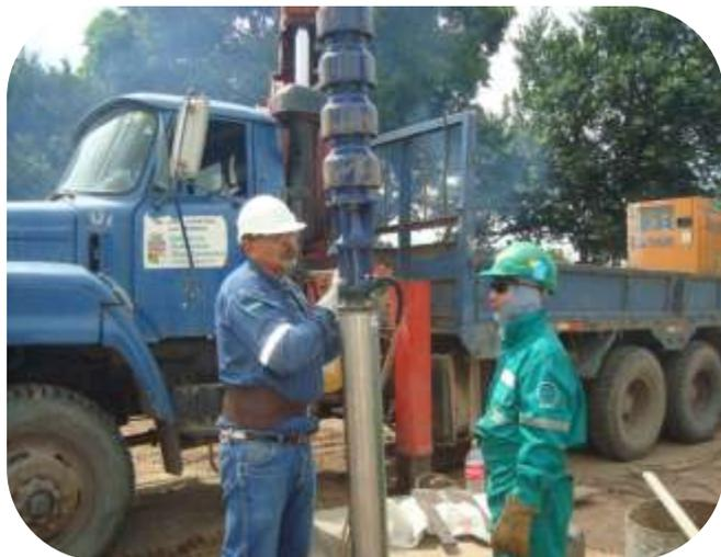
**Esta actividad, esta en estrecha relación con el Municipio, y permite el mantenimiento, limpieza y sopleteo de pozo, además del arreglo o en su defecto cambio de la bomba, ya sea manual o eléctrica, para que la comunidad no quede desabastecida del liquido elemento.**
